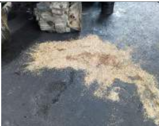
Apéndice 22 Uso de material absorbente en patio de trabajo.
